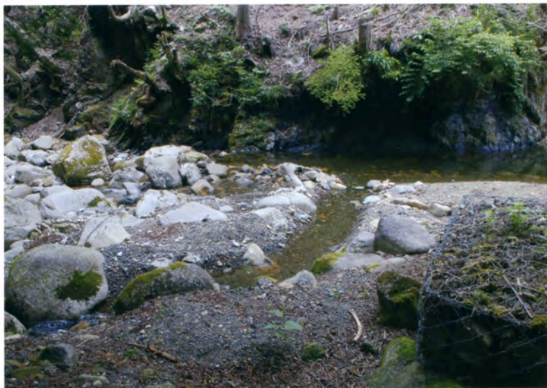
谷に造られた小さなダム
